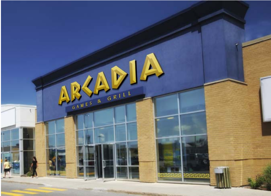
Afbeelding 35: Bord op gebouw
